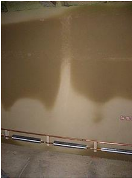
Wirkung von original san•cal Heizleisten bei frischem Lehmputz
