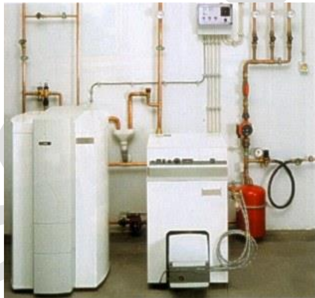
Beispiel der einfachen Kellerinstallation für 3 Heizkreise.
